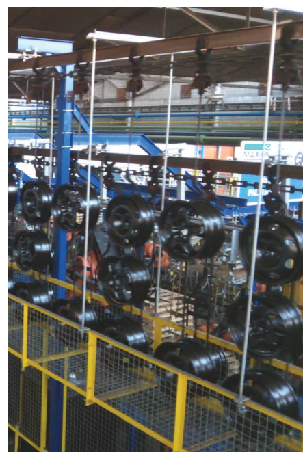
Instalación de transportador SLO PO 4
