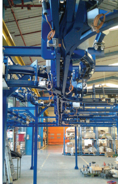
Instalación de transportador PFO 50+50 en la empresa Teka ( Santander )
